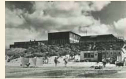
1960 Verbouwing strandhotel 'Beekman', Vlieland
