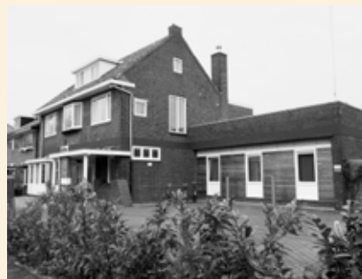
1938 Verbouwing garage Tolman, Leeuwarden, Bildtschestraat 35 en 37
