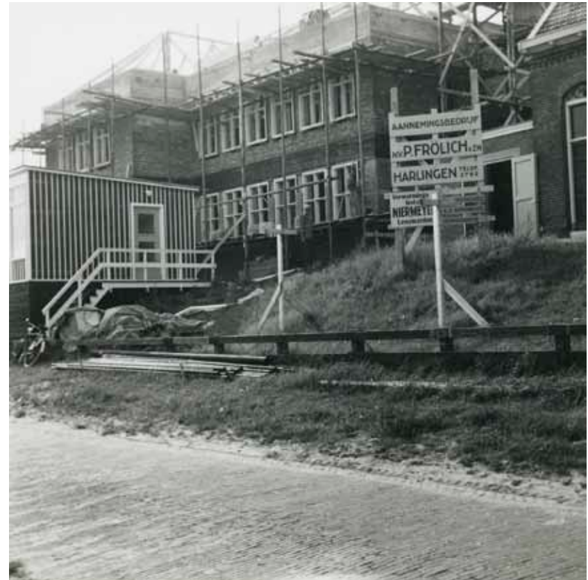
Telefoongebouw Terschelling tijdens de bouw
