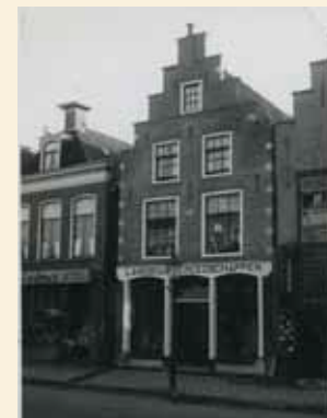
1936 Restauratie voorgevel, Franeker, Voorstraat 19
