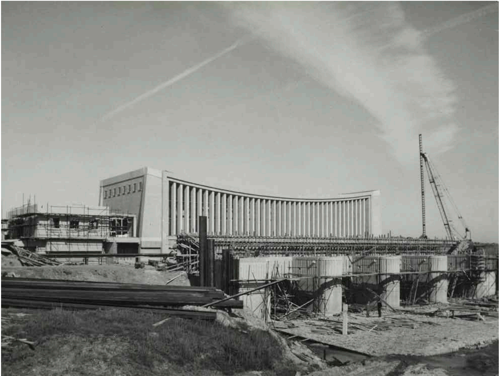
Het Hooglandgemaal in aanbouw
