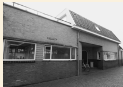
1932 Complex van zeven woningen en kantoor, Harlingen, Westerstraat 1 t/m 15 (oneven nrs.)
