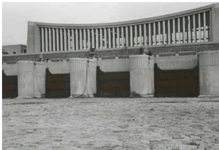
Het Hooglandgemaal in aanbouw
