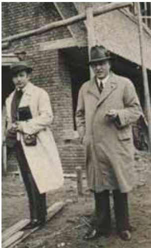
Piet de Vries (links) met de heer Hooysschuur bij de bouw van de woonhuizen aan de Midlumerlaan te Harlingen (1935)
