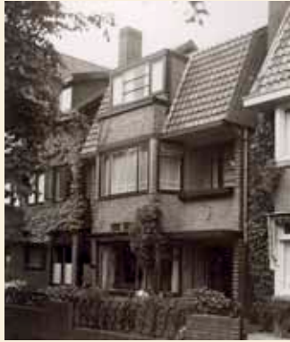
1928 Woonhuis, Leeuwarden, Spanjaardslaan 126
