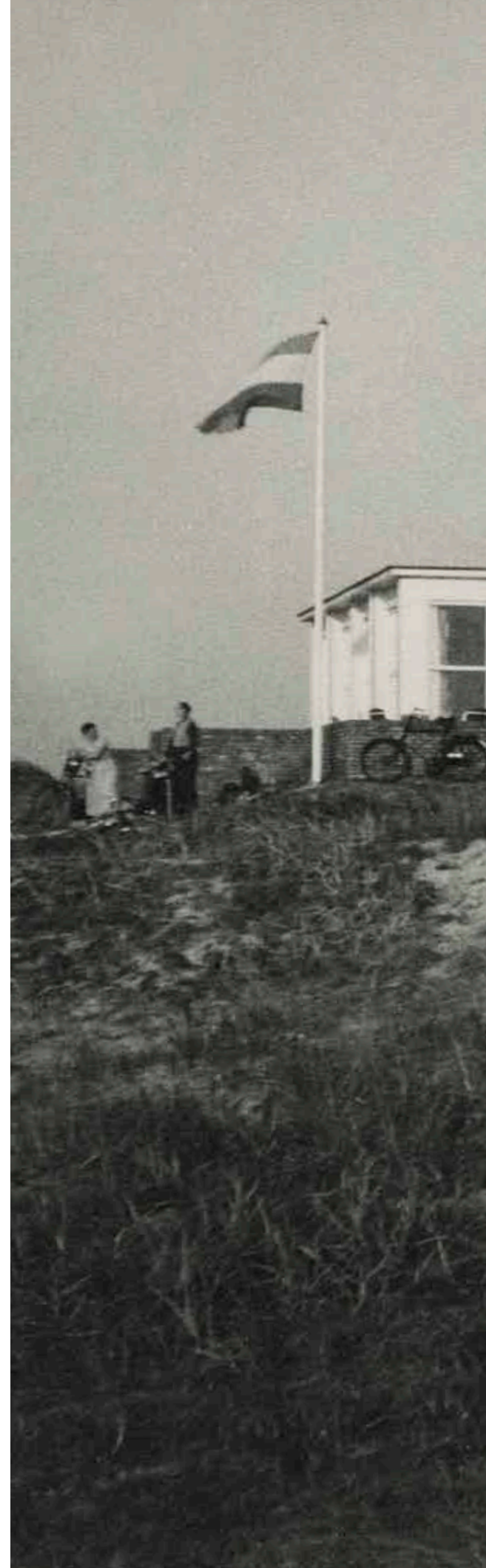
Paal 8 voor eerste verbouwing
