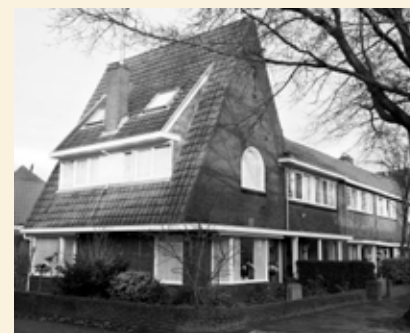
1933 Dubbele woning, Leeuwarden (Huizum), hoekbebouwing Ferd. Bolstraat 44-46 (hoek Govert Flinkstraat)
