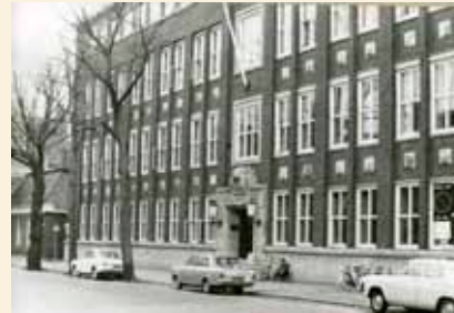
1954 PTT Telefondistrictsgebouw, Leeuwarden, Tweebaksmarkt 23 (uitbreidingen in 1963 en 1968)
